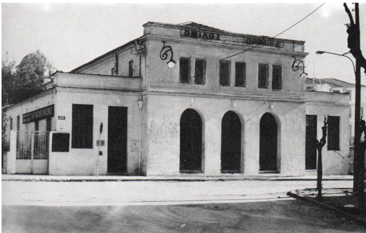
Εικόνα 34. Πρόσοψη του ιστορικού κτηρίου του Ομίλου «Ορφέα» 174
