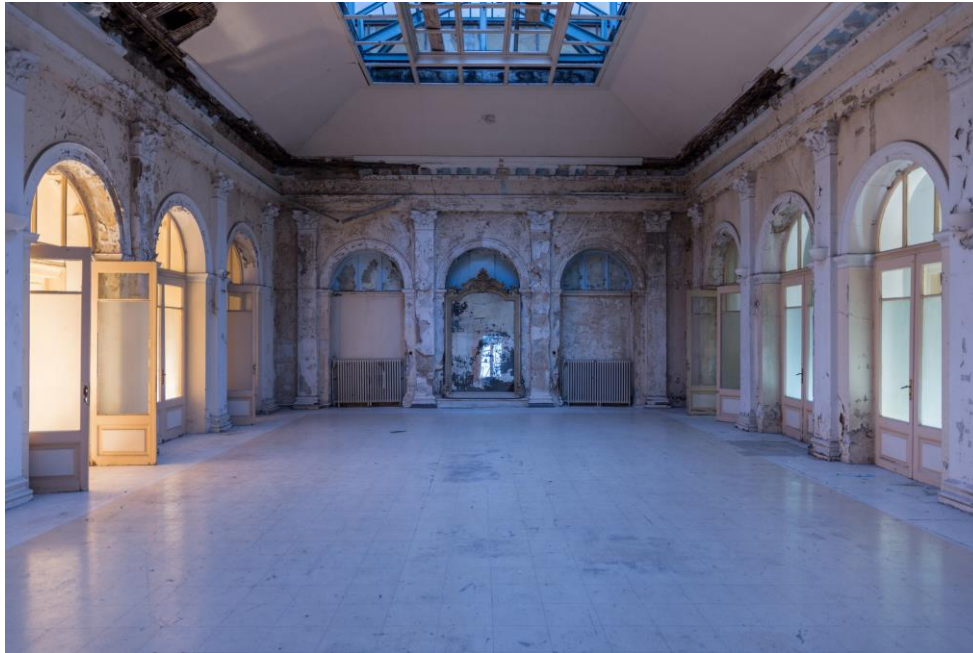
Εικόνα 9: Η κεντρική αίθουσα του πρώτου ορόφου μετά τις εργασίες συντήρησης. 36
