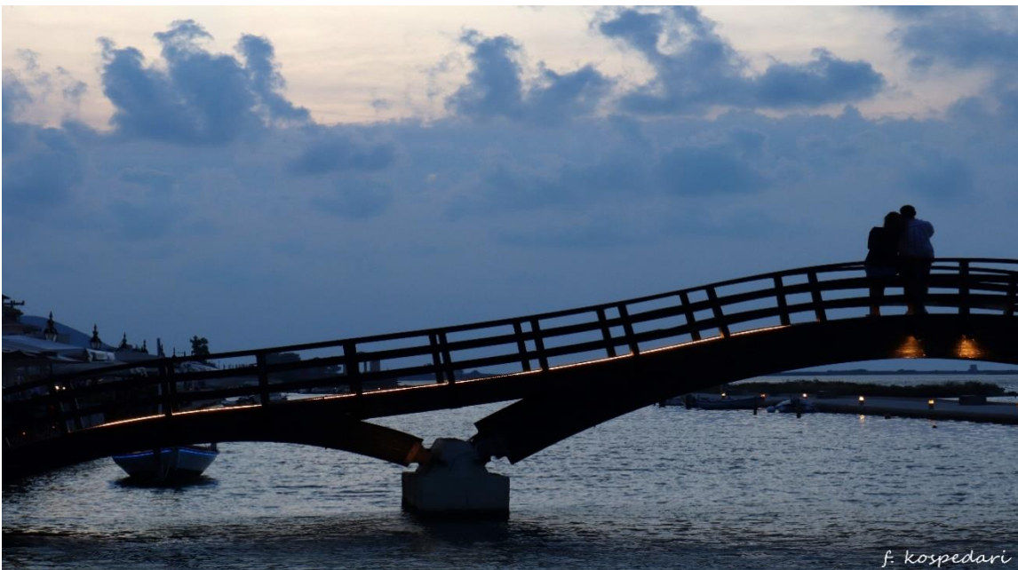
Εικόνα 4: Στιγμιότυπο από τη ξύλινη γέφυρα
