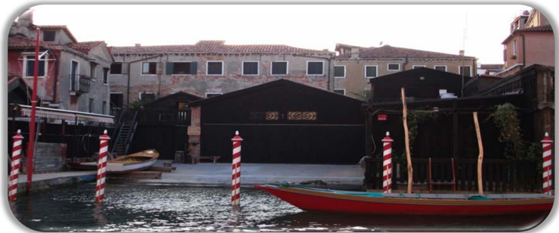
1. Στο σημείο αυτό στεγαζόταν το θέατρο Σάντι Τζιοβάνι ε Πάολο κατά τον 17 ο αιώνα. Στις μέρες μας αποτελεί εργαστήριο επισκευής βαρκών, όπως μαρτυρεί και η εικόνα.
