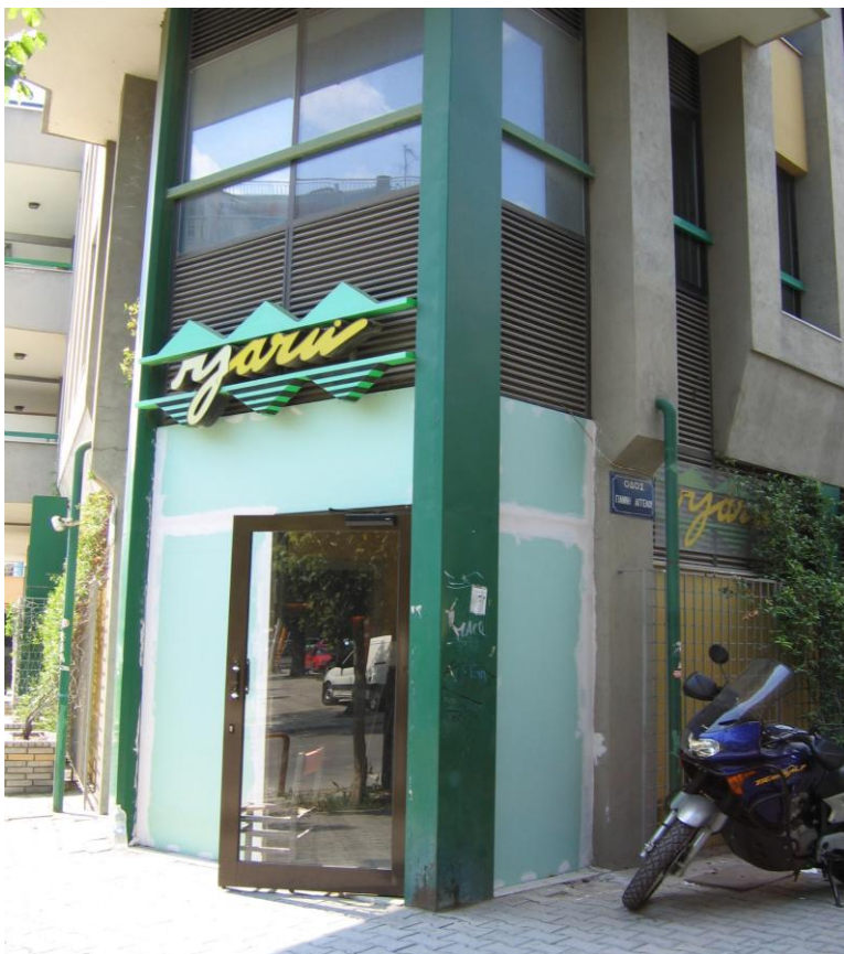
Εικ 26 . Η εξωτερική όψη κατά την περίοδο της ανακαίνισης το καλοκαίρι του 2005. Πηγή: Προσωπικό αρχείο Δημήτρη Κεχαγιά και Βίκυς Γκούνη.
