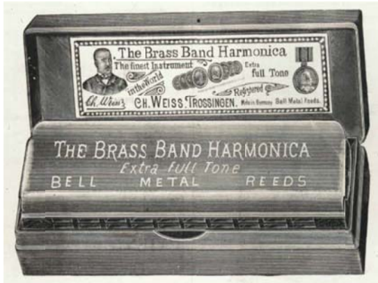
Εικόνα 13. Το μοντέλο του Weiß (με προσωπογραφία). Στο μέσον του οργάνου γράφει Extra Full Tone , ενδεικτικό πιθανόν της καινοτομίας που έγινε. Από κάτω γράφει BELL METAL REEDS , όπου BELL νοείται ένα μπρούτζινο κράμα αποτελούμενο από 78% χαλκό και 22% κασίτερο. Φωτο. από το MUSIC TRADE REVIEW , Δεκέμβριος 1897: 27
